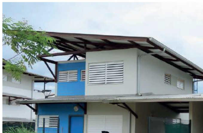
Toiture à une pente désolidarisée - ZAC Concorde Rochambeau
