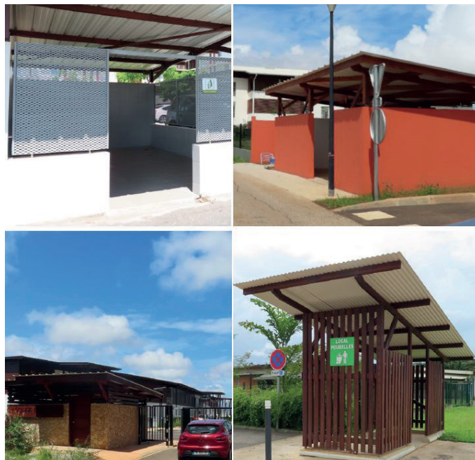
Une intégration qualitative des locaux poubelles
