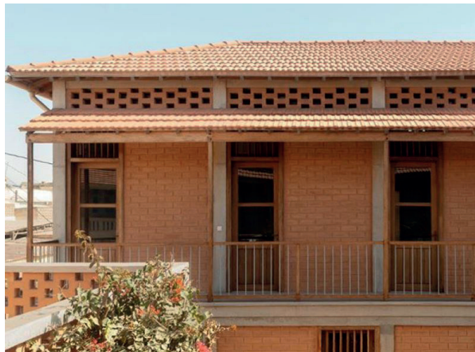
Utilisation de la brique structurale
